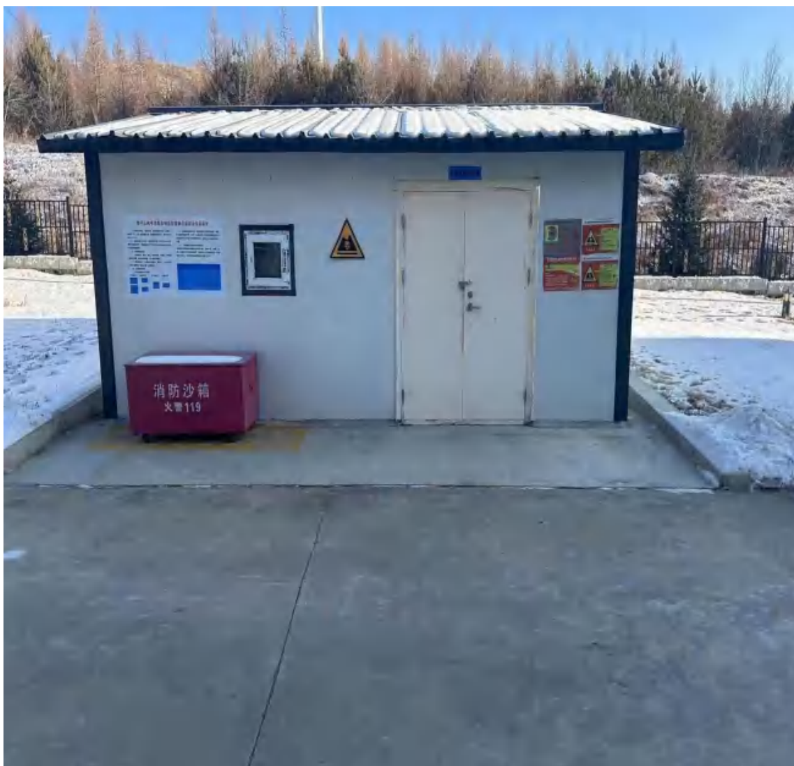
附图 8 危废暂存间图片
