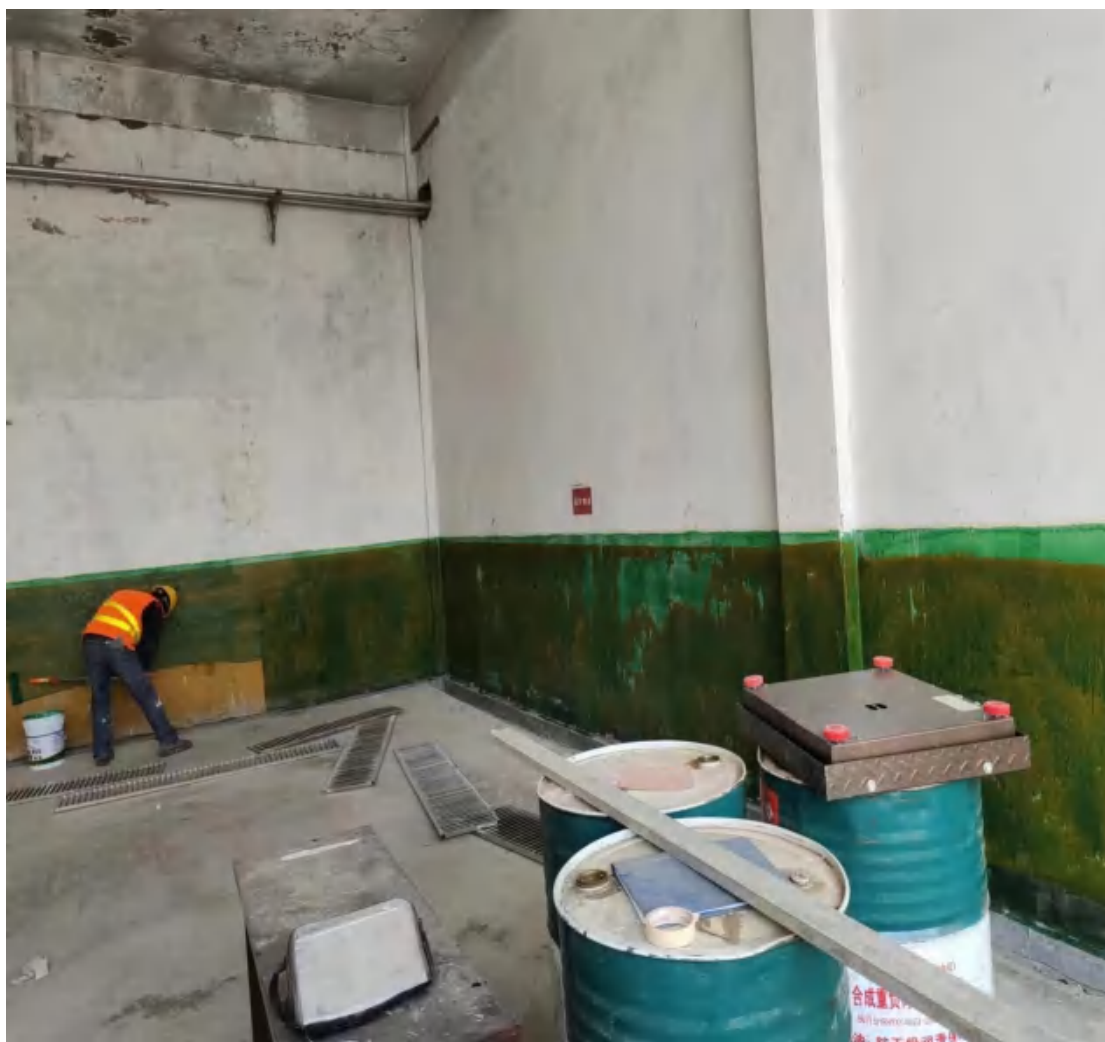
附图 8 铺防渗材料现场
