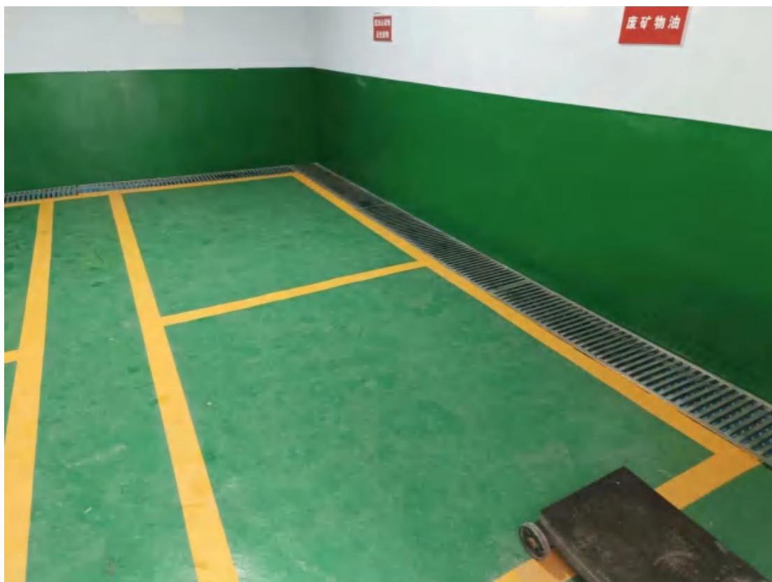
附图 8 铺防渗材料现场
