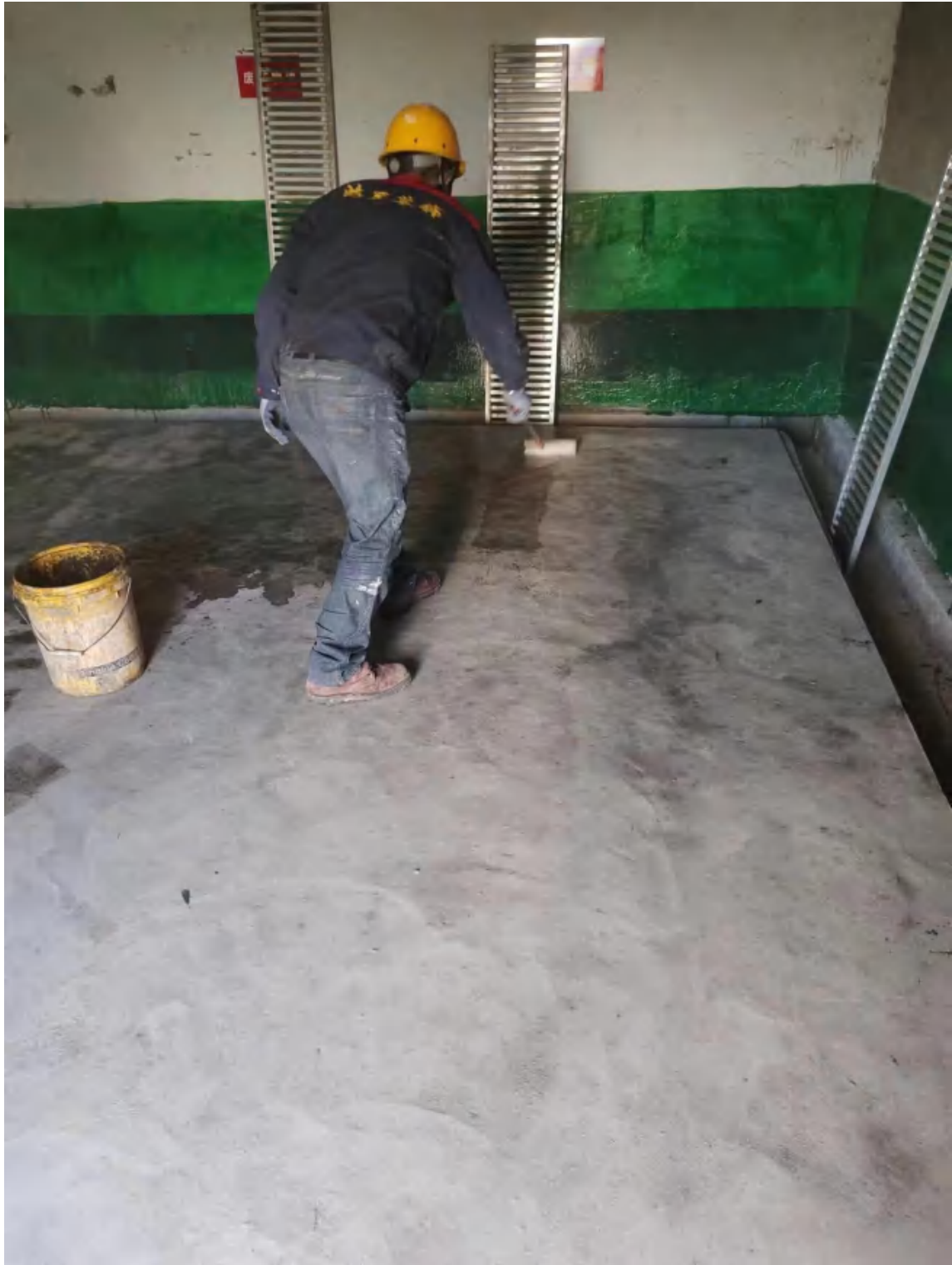
附图 8 铺防渗材料现场
