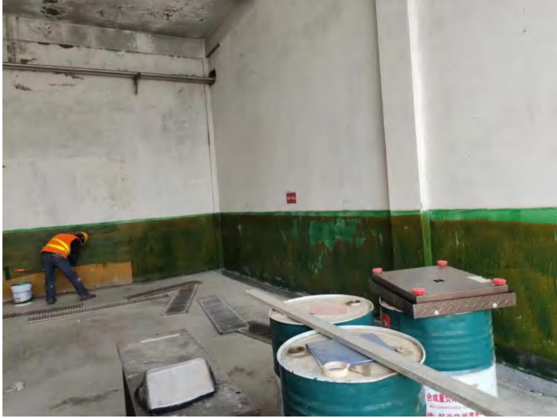
附图 8 铺防渗材料现场
