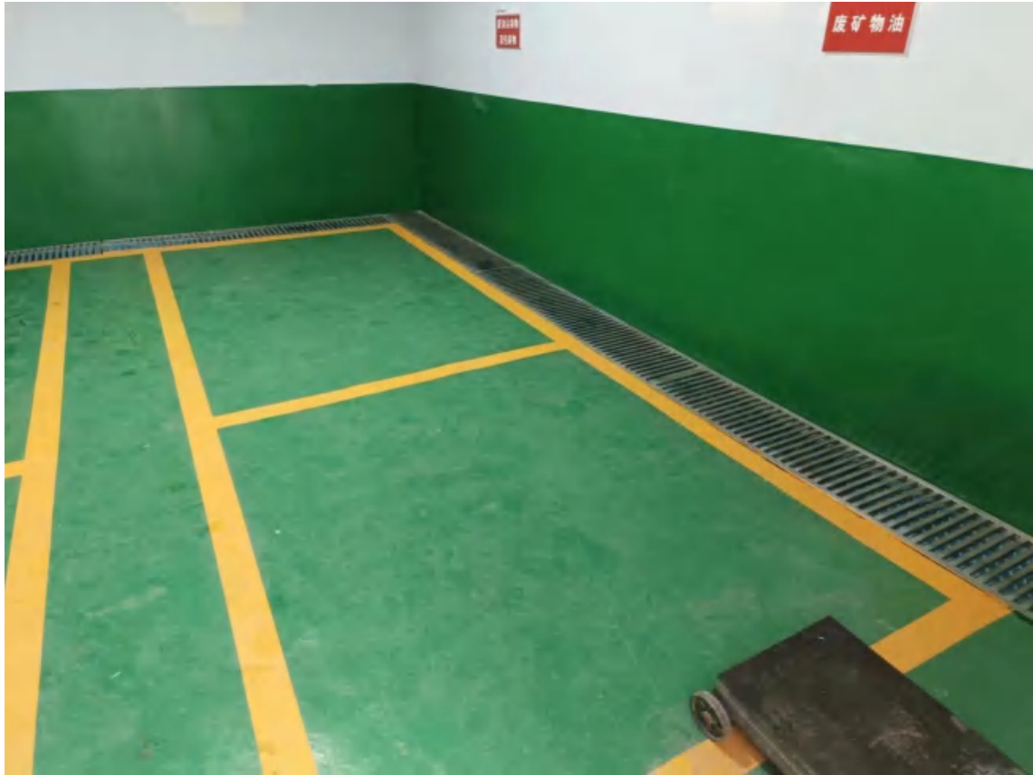
附图 8 铺防渗材料现场
